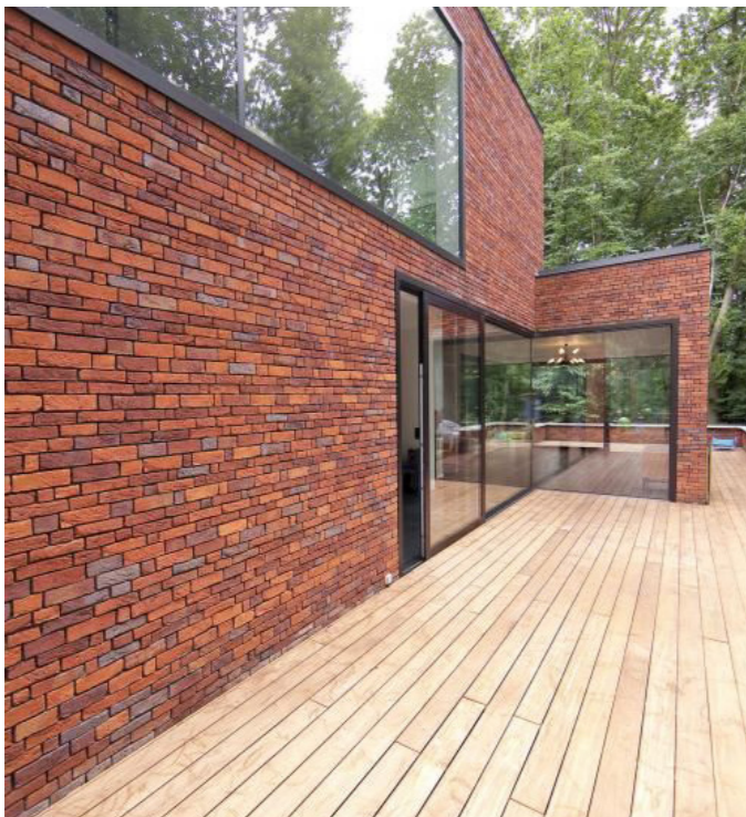
Referentie relatie dek met nieuwe metselwerk gebouwen
