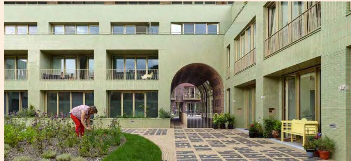
Doorgangen door de woonblokken maken het hele gebied toegankelijk.
