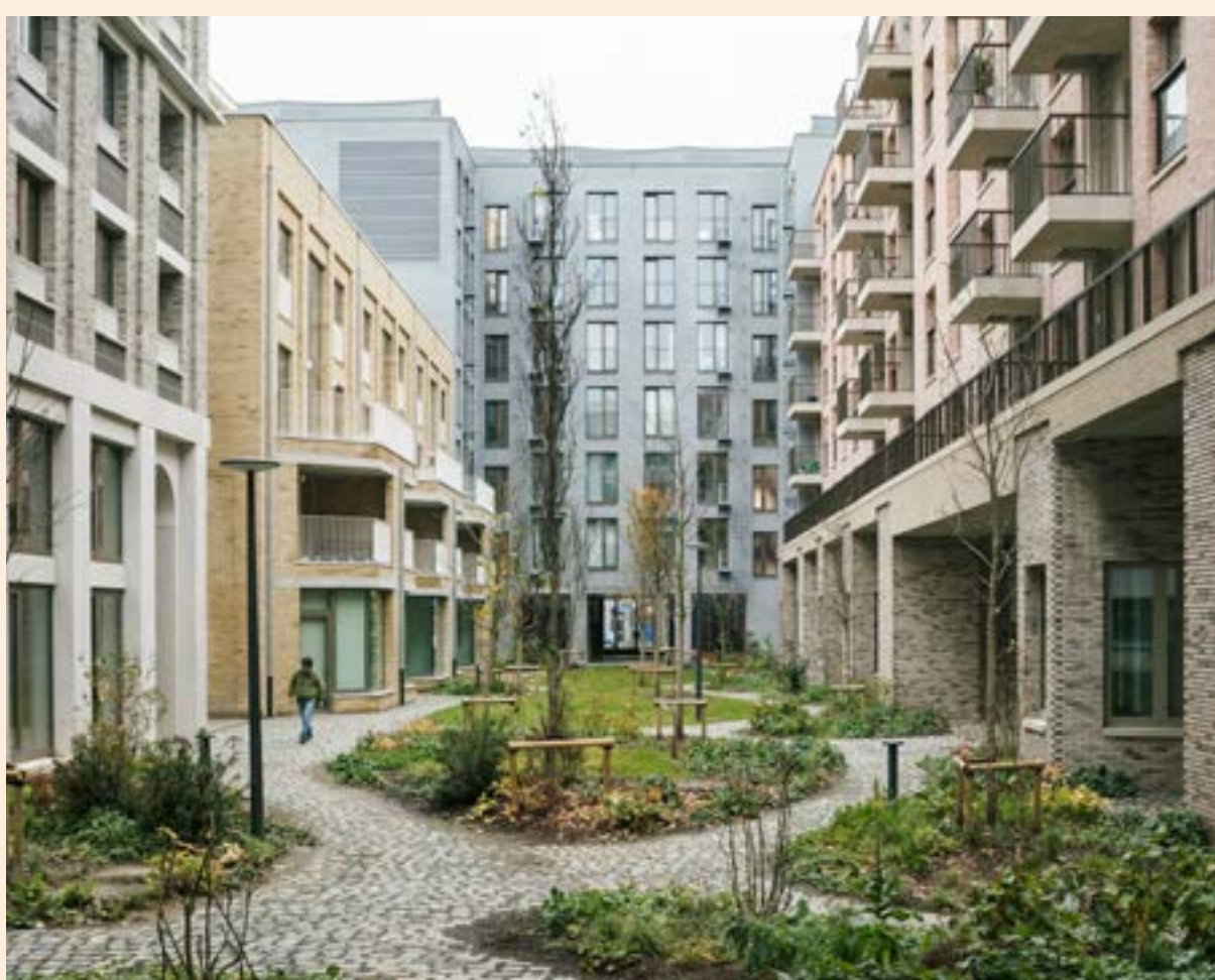
Gebouwen met verschillend uiterlijk wisselen elkaar af.
