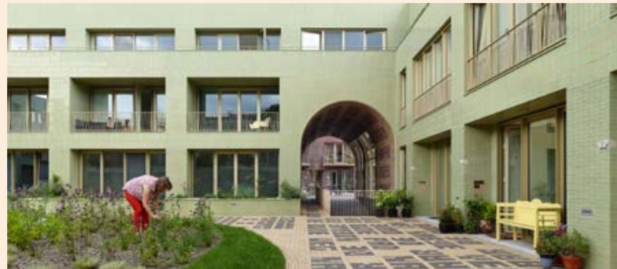
Doorgangen door de woonblokken maken het hele gebied toegankelijk.
