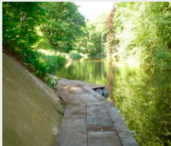
| Amfibieëntunnel onder Engelandlaan
