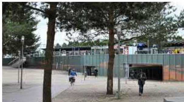
Plein met glooiende overgang naar fietstunnel
