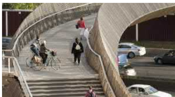
Toegankelijke en aantrekkelijke passerelle
